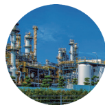
プラント設備
